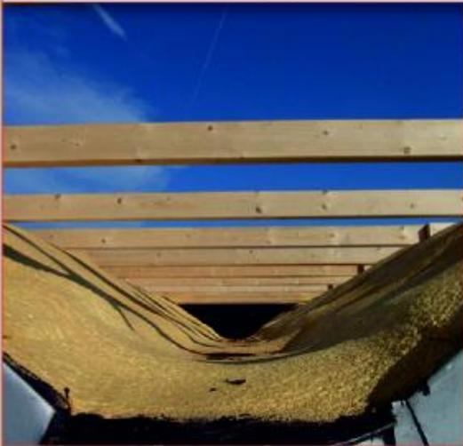
Vorteil: Wärmedämmung nach EnEV 2009 als Aufdachdämmung. Geschlossene und fugenfreie Dachdämmung mit fixierenden Eigenschaften als PUR Ortschaum mit hohem Dämmwert  $\lambda=0,028 \text{ W/mK}$
