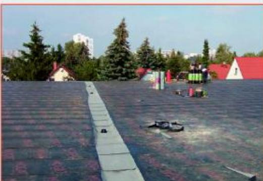
Vorteil: Die Dachentwässerung ist als offene Rinne ausgebildet. Dadurch kann die Anzahl der Dacheinläufe um 60% reduziert werden.
