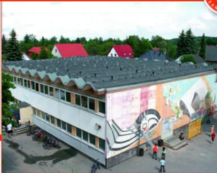
Für Fertigteilbauten mit VT-Faltendach am Beispiel einer Sporthalle
